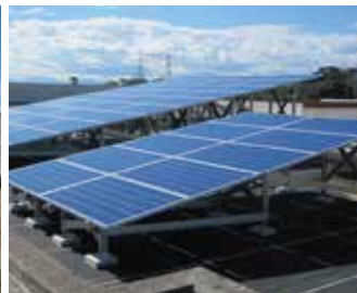
陸屋根（アンカー）
